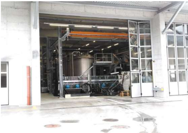
Piazzale di scarico (fig.1)
