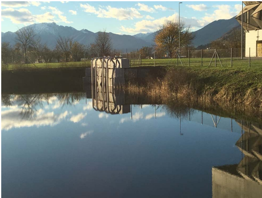
Presa d'acqua per i pompieri
