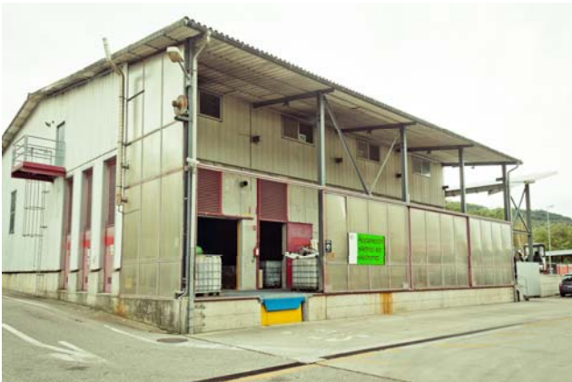
Lo scarico dei materiali elettrici-elettronici
